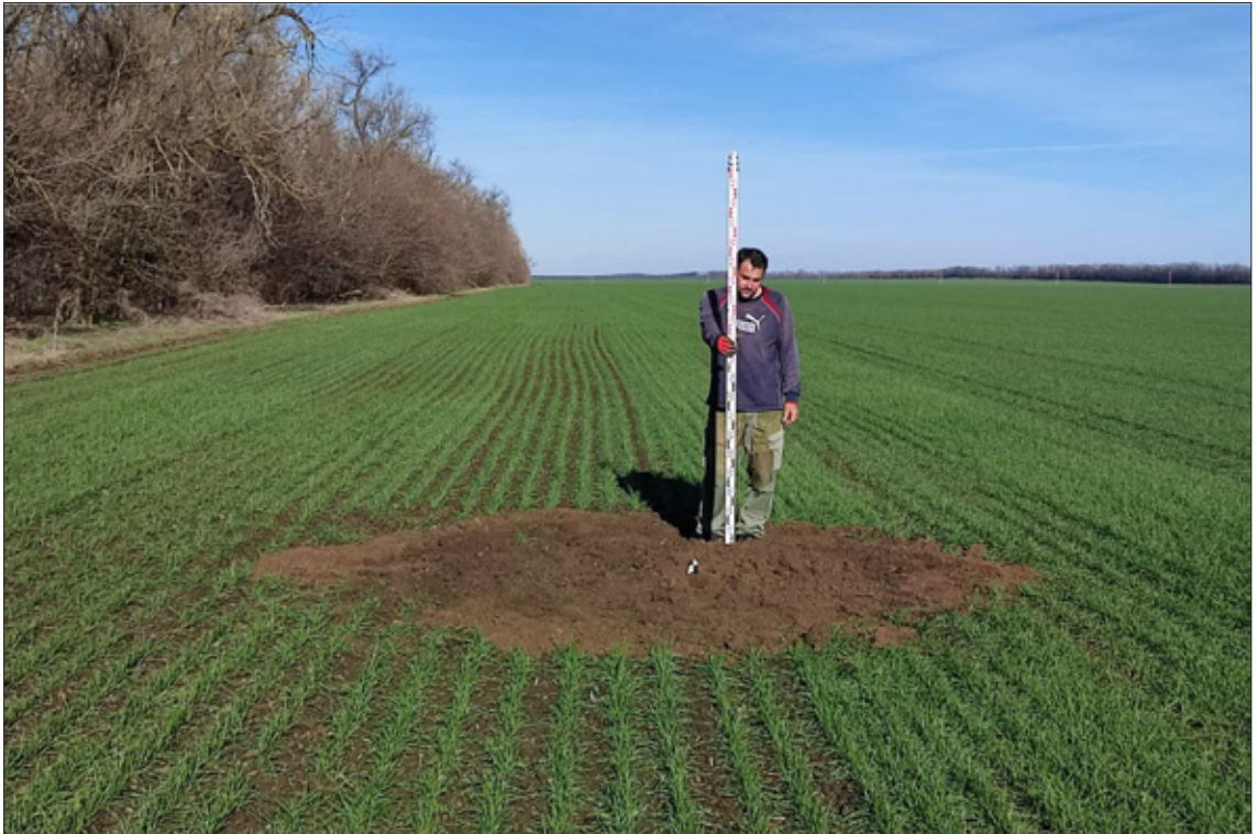
Рис. 90. Труновская ВЭС. Шурф 16. После рекультивации. Вид с юга.
