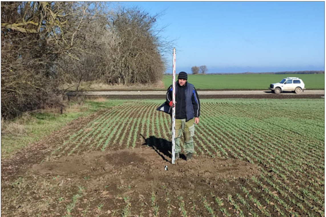
Рис. 78. Труновская ВЭС. Шурф 13. После рекультивации. Вид с юга.
