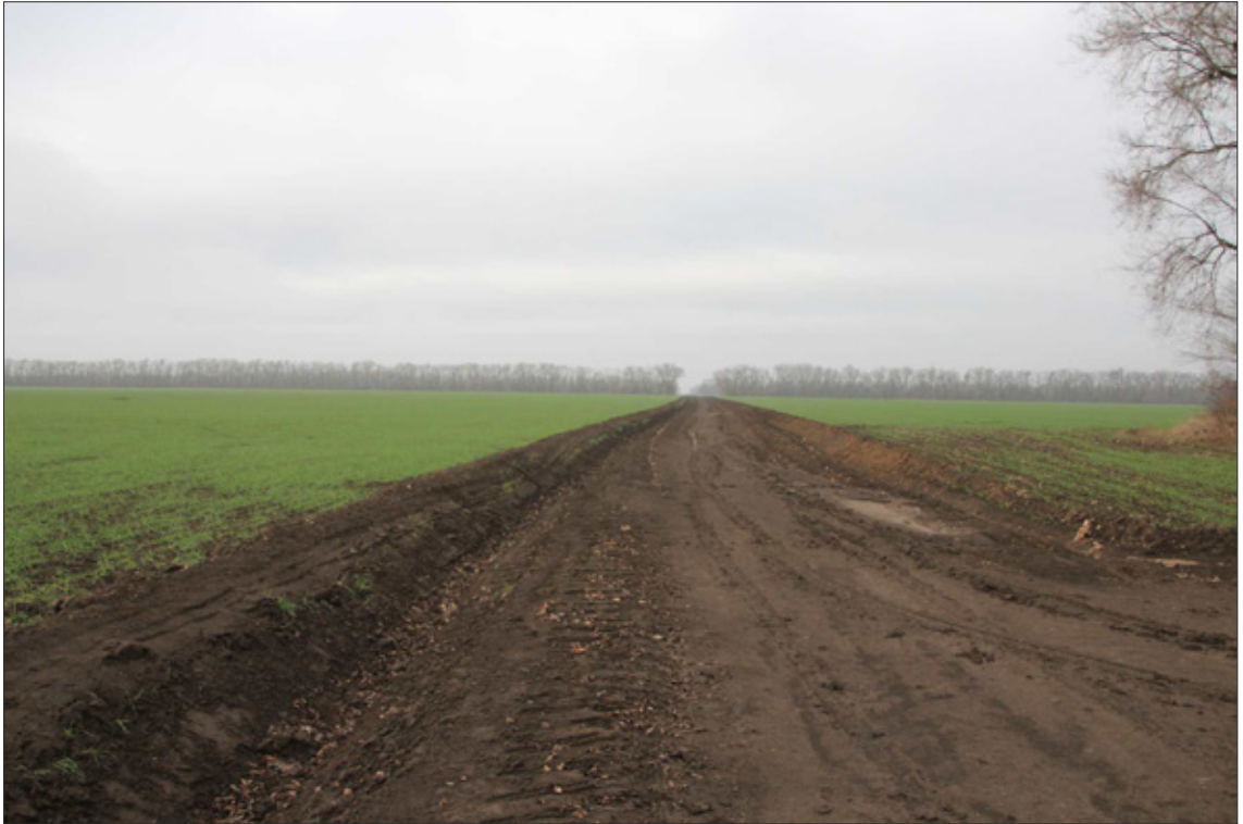
Рис. 12. Труновская ВЭС. Точка фотофиксации 5. Вид с востока.
