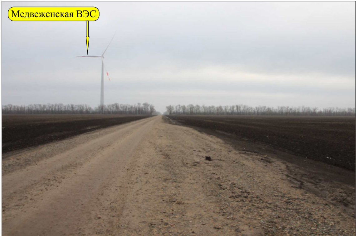
Рис. 6. Труновская ВЭС. Точка фотофиксации 1. Вид с запада.
