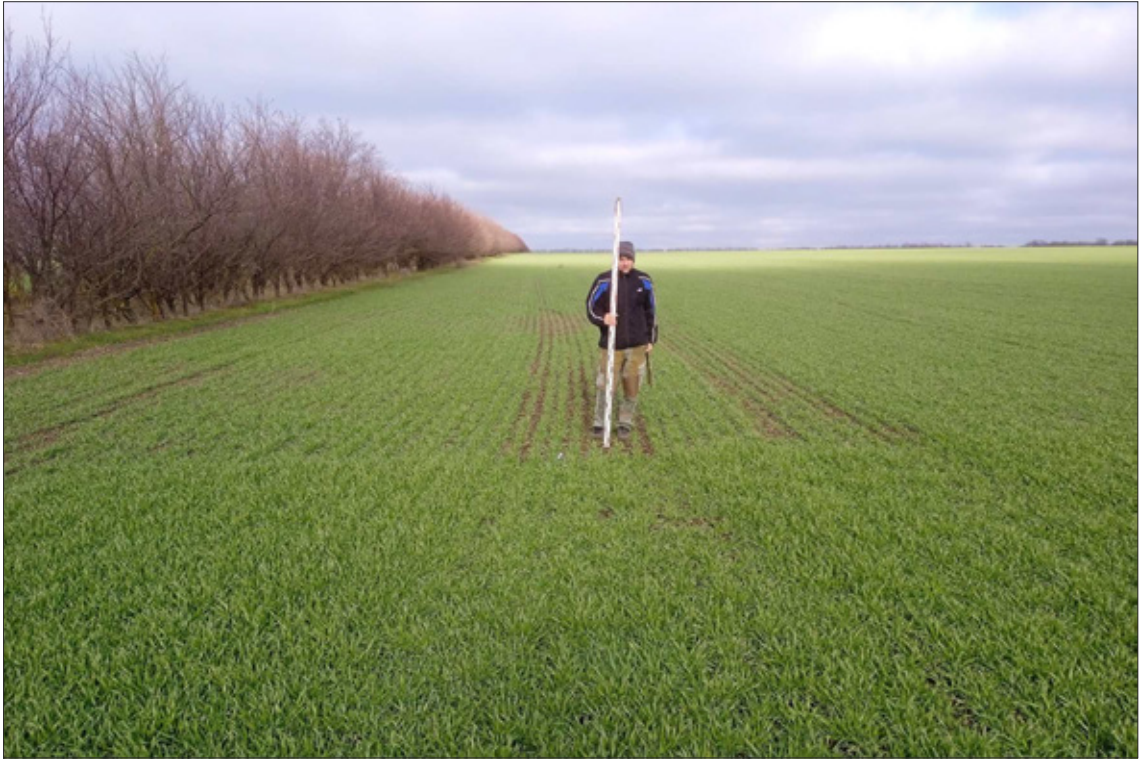
Рис. 27. Труновская ВЭС. Шурф 1. До начала работ. Вид с юга.
