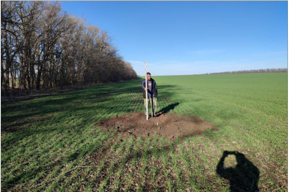
Рис. 54. Труновская ВЭС. Шурф 7. После рекультивации. Вид с юга.
