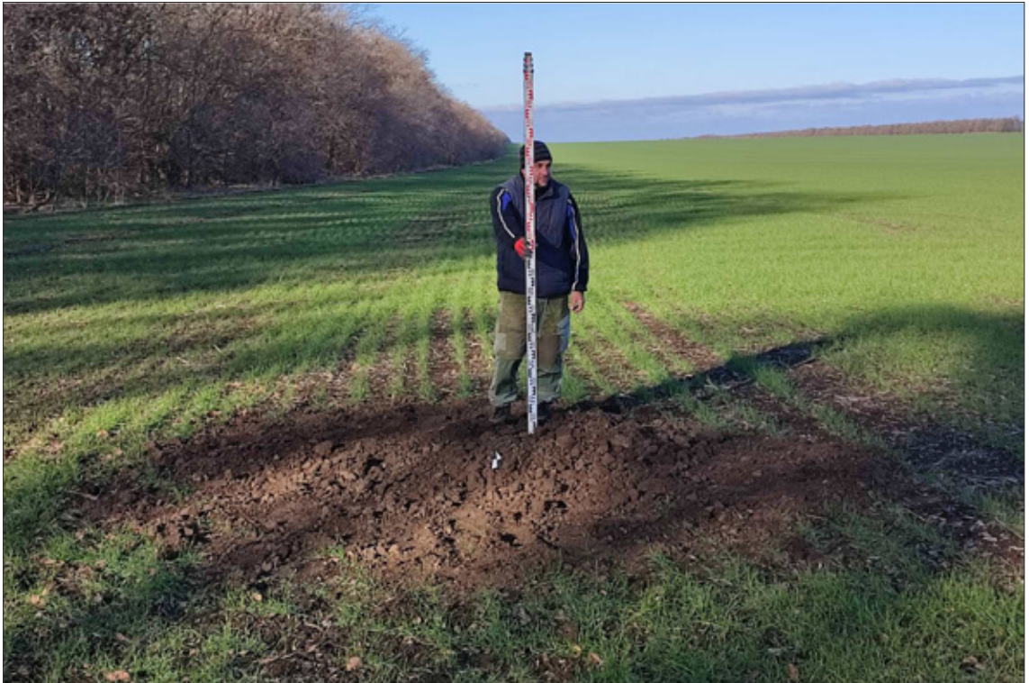
Рис. 46. Труновская ВЭС. Шурф 5. После рекультивации. Вид с юга.
